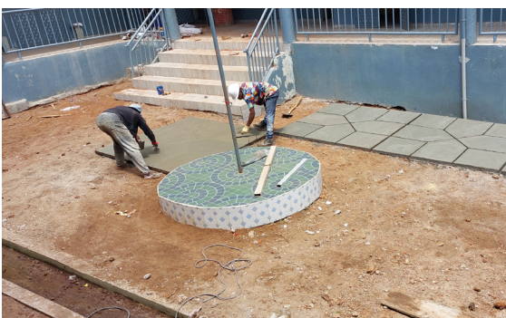
De mal is volgestort en wordt nu vlak af gestreken. Daarna wordt de mal opgetild.
